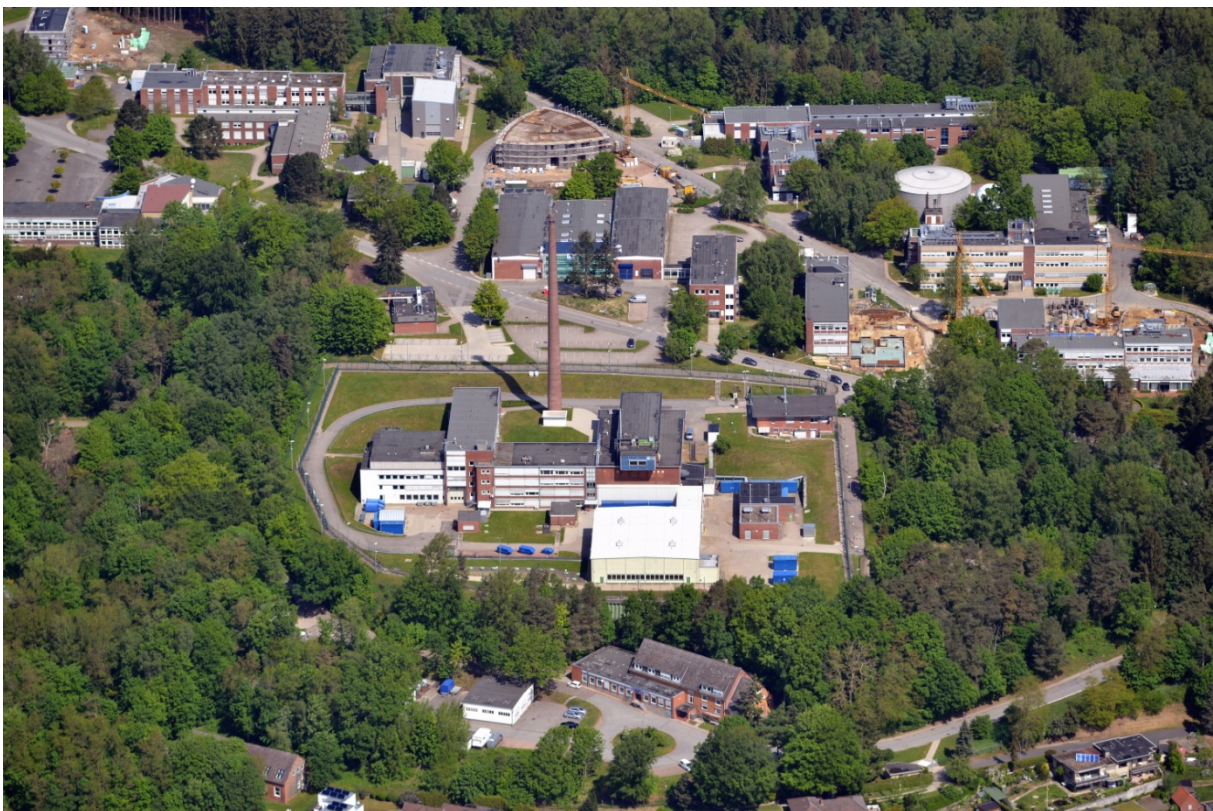
Abbildung 5-1: Luftbild der FRG und des HL sowie der TBH (Stand: 2016)
